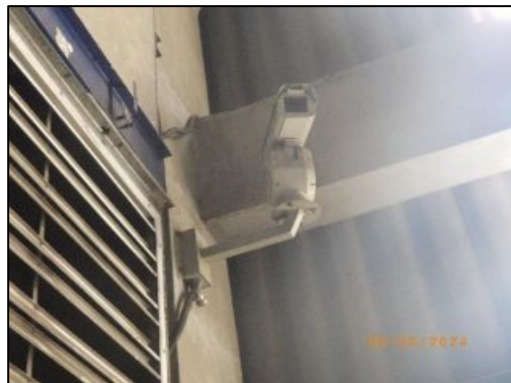
รูปที่ 2-64 การติดตั้งกล้องวงจรปิด สำหรับตรวจสอบระดับน้ำ ของหม้อไอน้ำ
