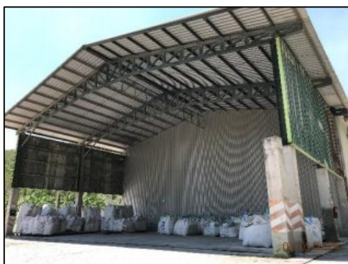
รูปที่ 2-38 สถานที่จัดเก็บกากของเสีย ที่มีหลังคาปิดคลุมและพื้นคอนกรีต
