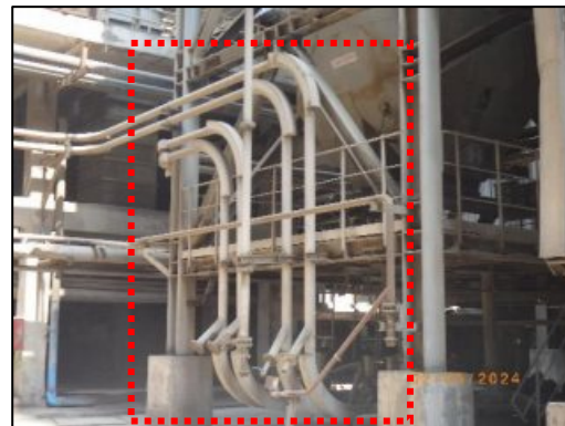
รูปที่ 2-10 ระบบ Limestone Injection
