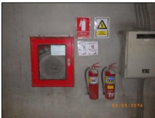
รูปที่ 2-46 ท่อดับเพลิงและตู้เก็บสายดับเพลิง
