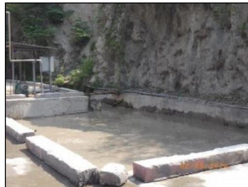
รูปที่ 2-62 บ่อพักน้ำ Blow Down ใต้ CFBC Boiler
