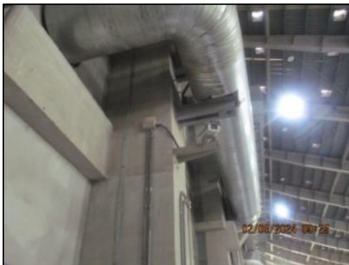
รูปที่ 2-40 ผนังกันความร้อนของระบบท่อไอน้ำ
