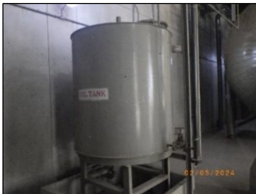
รูปที่ 2-69 Emergency Gravity Oil Tank
