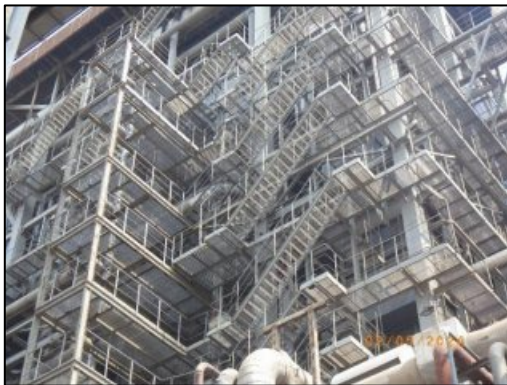
รูปที่ 2-57 CFBC Boiler ที่มีทางเดินและบันได พร้อมราวกันตก
