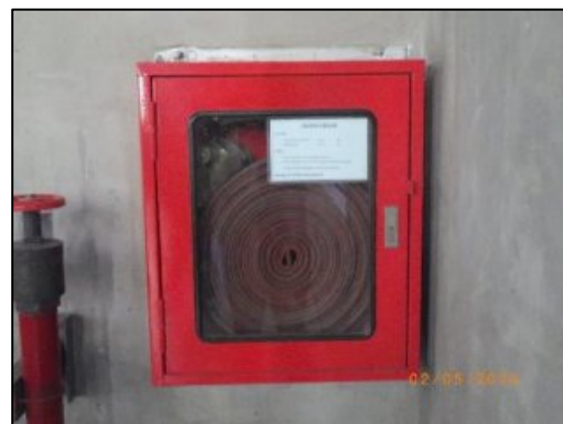
รูปที่ 2-46 ท่อดับเพลิงและตู้เก็บสายดับเพลิง
