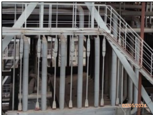
รูปที่ 2-63 Rapid Drain Piping System ของหม้อไอน้ำ
